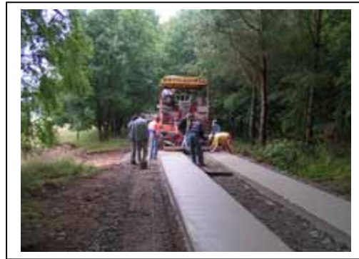
Die Bauarbeiten sind in vollem Gange
